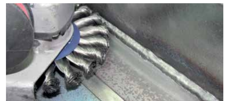
Schweißnahtreinigung mit Rundbürste gezopft
