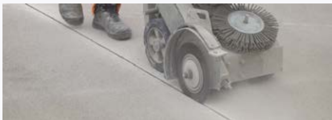
Čistící kartáč na spáry používaný při stavbě silnic
