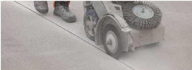
Voegenborstel gebruikt in de wegenbouw
